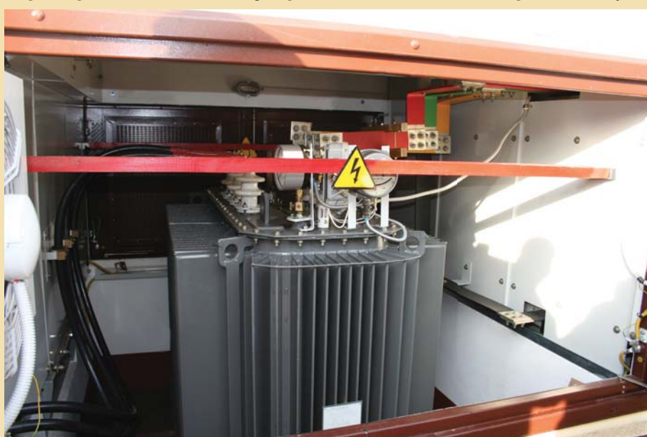
Отсек трансформатора
